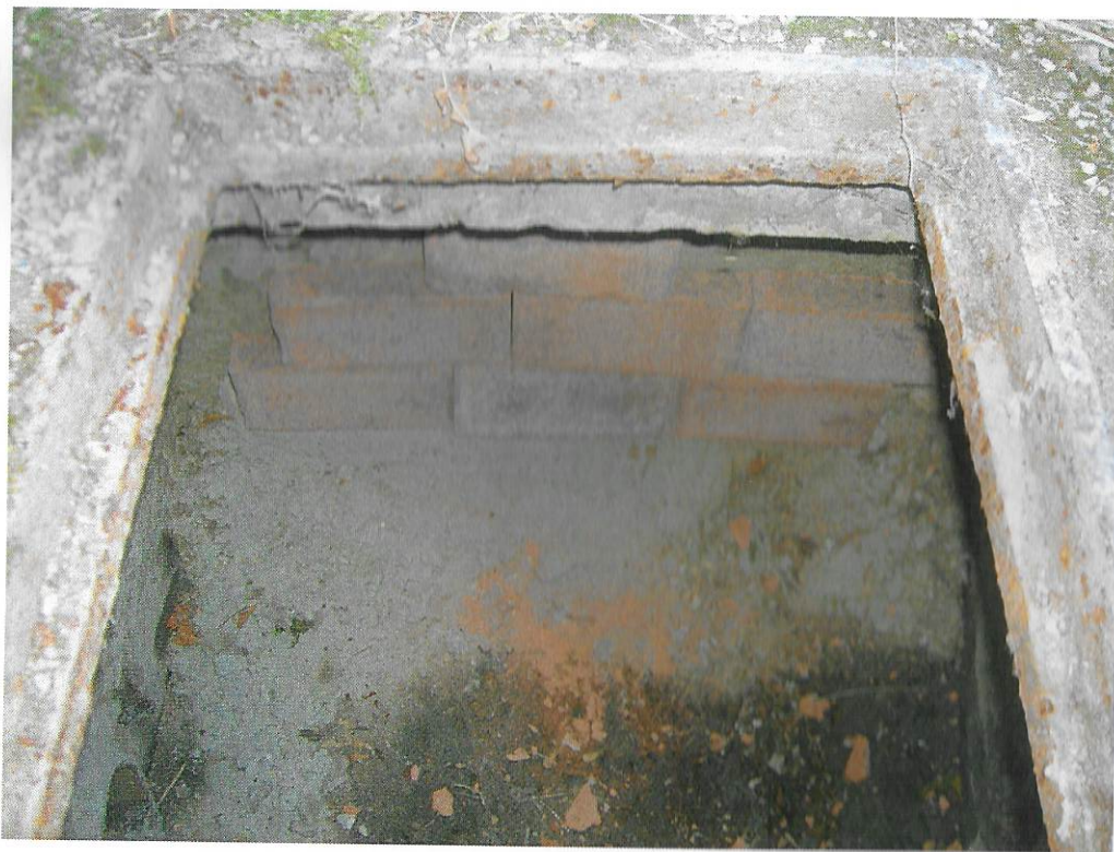
Foto 1 – dettaglio pozzetto N. 2 con ingresso da sud "murato".
