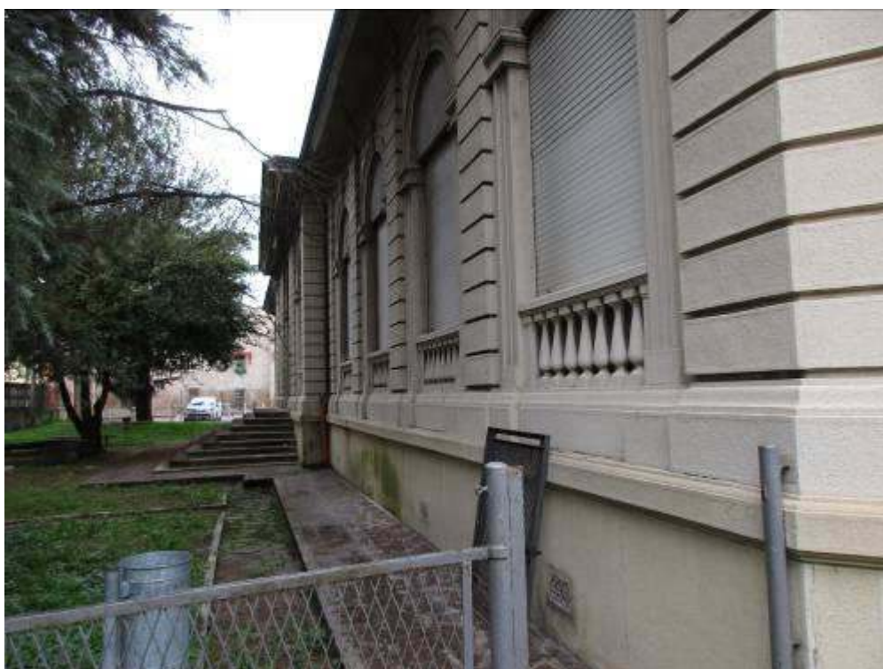
Foto 12, edificio 48 ex Dispensario
