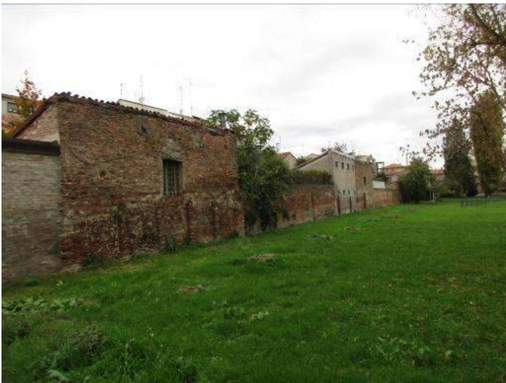
Foto 16, giardino ex eliporto e retro fabbricati via Mortara
