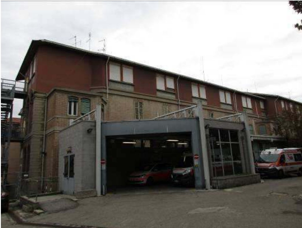
Foto 3 ex pronto soccorso (edificio 32)
