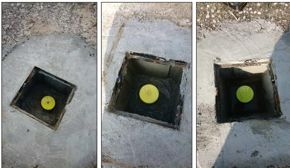
Figura 5.4. Pozzetti dei piezometri completati. PZ1 (sinistra), PZ2 (centro) e PZ3 (destra)
