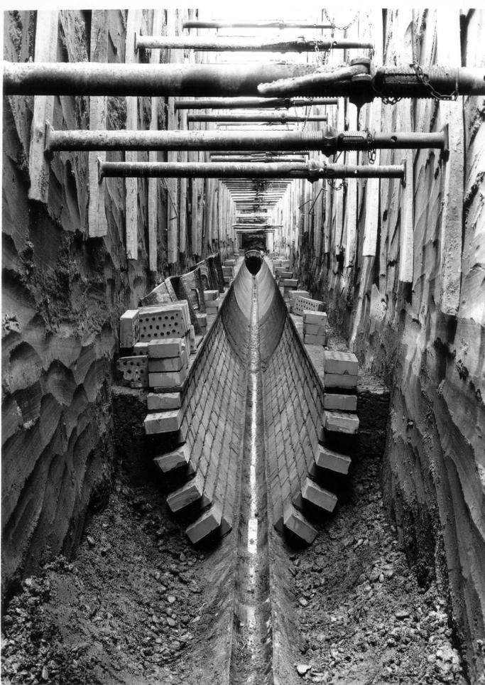
Fognatura di via Azzurra a Bologna, costruzione di un condotto tipo ONI in muratura con sottofondo in conglomerato cementizio (1966)
