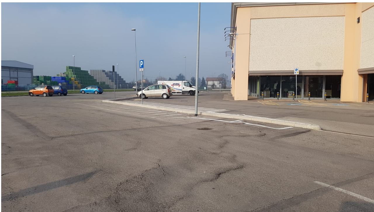
FOTO 5 - vista verso edificio esistente da via Argine Codilupo
