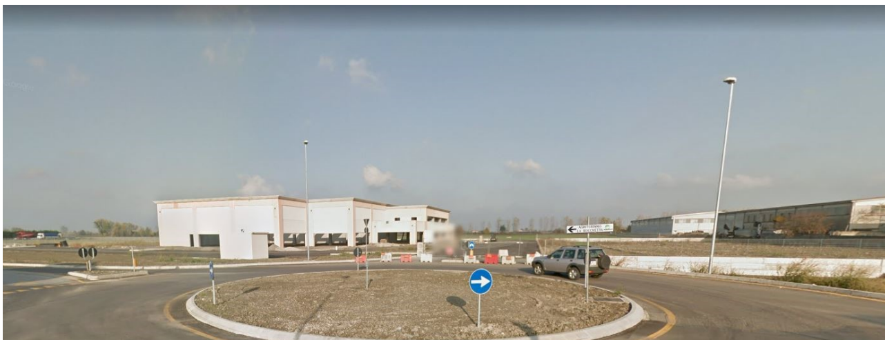
FOTO 1 – rotonda via Frasbalda
