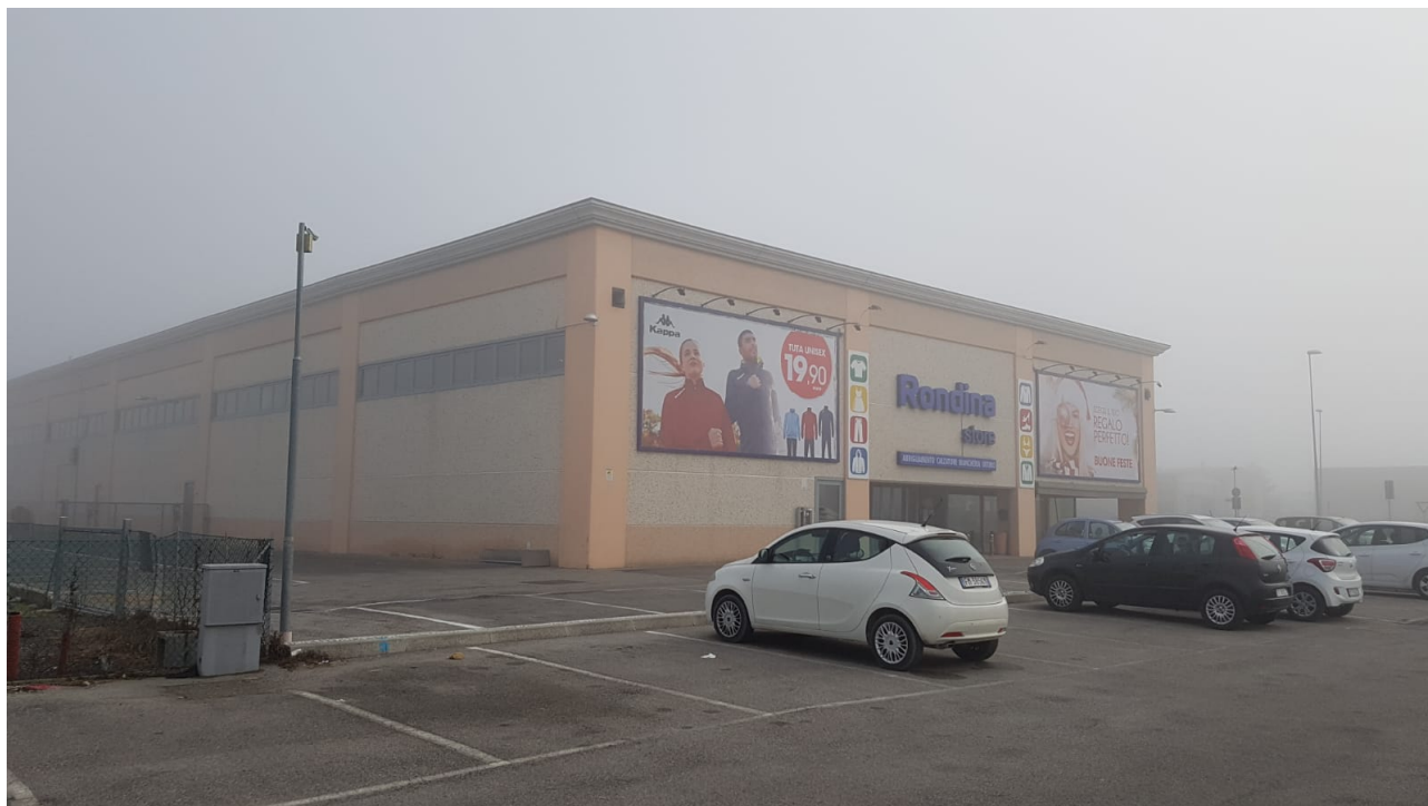
FOTO 6 - vista verso edificio esistente da via Cognola
