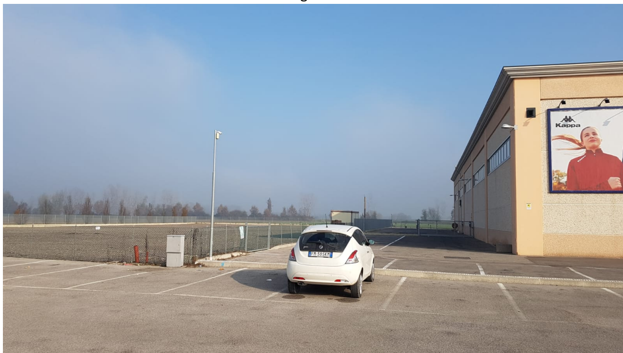
FOTO 7 - vista verso edificio esistente da via Cognola
