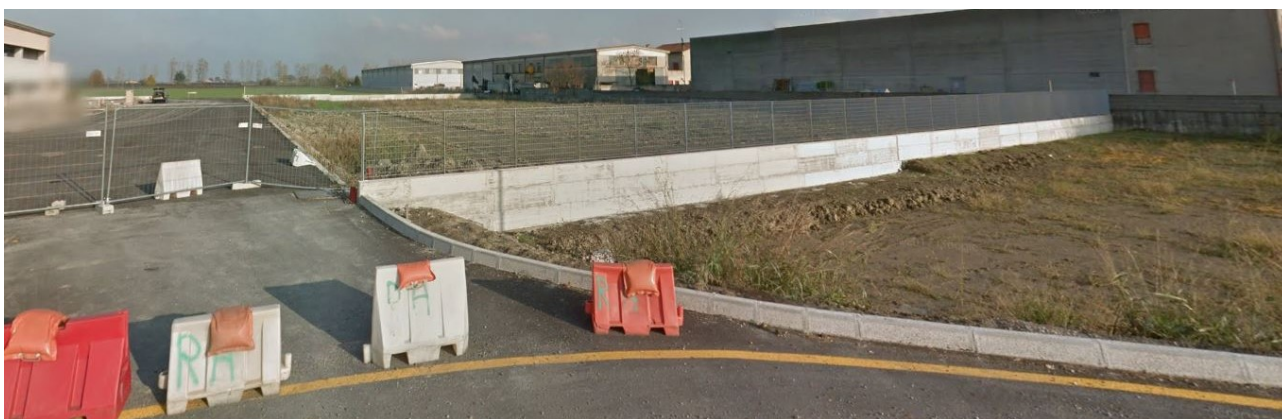
FOTO 3 – vista verso Lotto 3
