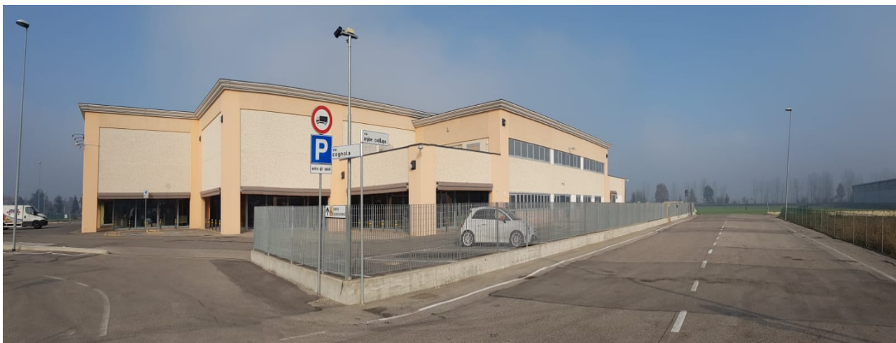
FOTO 4 – vista verso edificio esistente tra via Cognola e via Argine Codilupo
