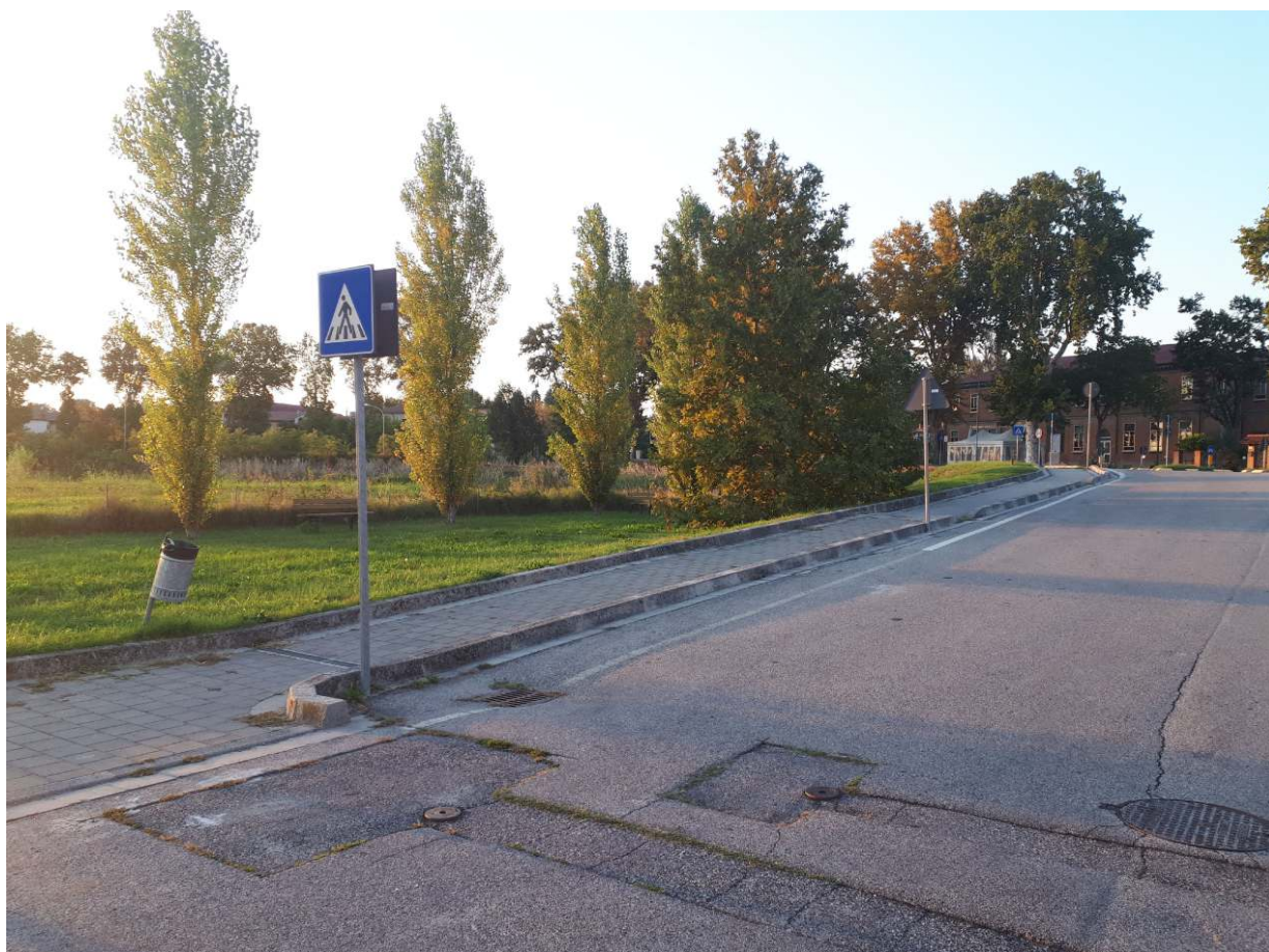
Percorso pedonale esistente su via Don Giulio Zerbini
