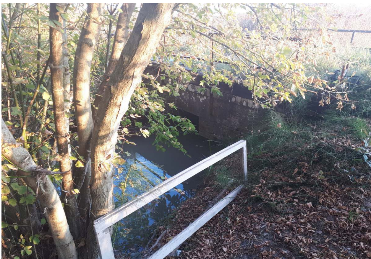
Invaso e attraversamento ferroviario
