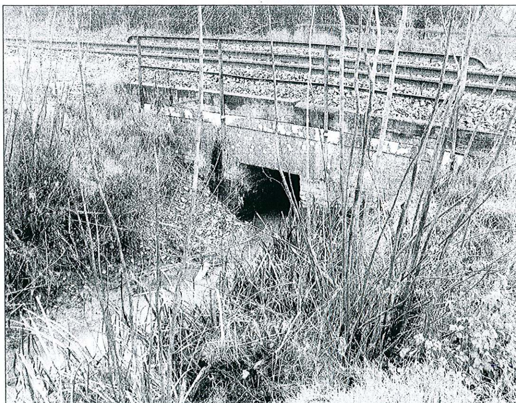
Vista Fotografica n° 1b: mostra parte dell'invaso naturale, di cui alla VF n° 1 sopra, ubicato nel parchetto pubblico di proprietà del Comune di Ferrara e collocato a Sud-Est dell'urbanizzazione denominata " Dalla Villa Spa " – 2° Stralcio , a Cona (FE)
