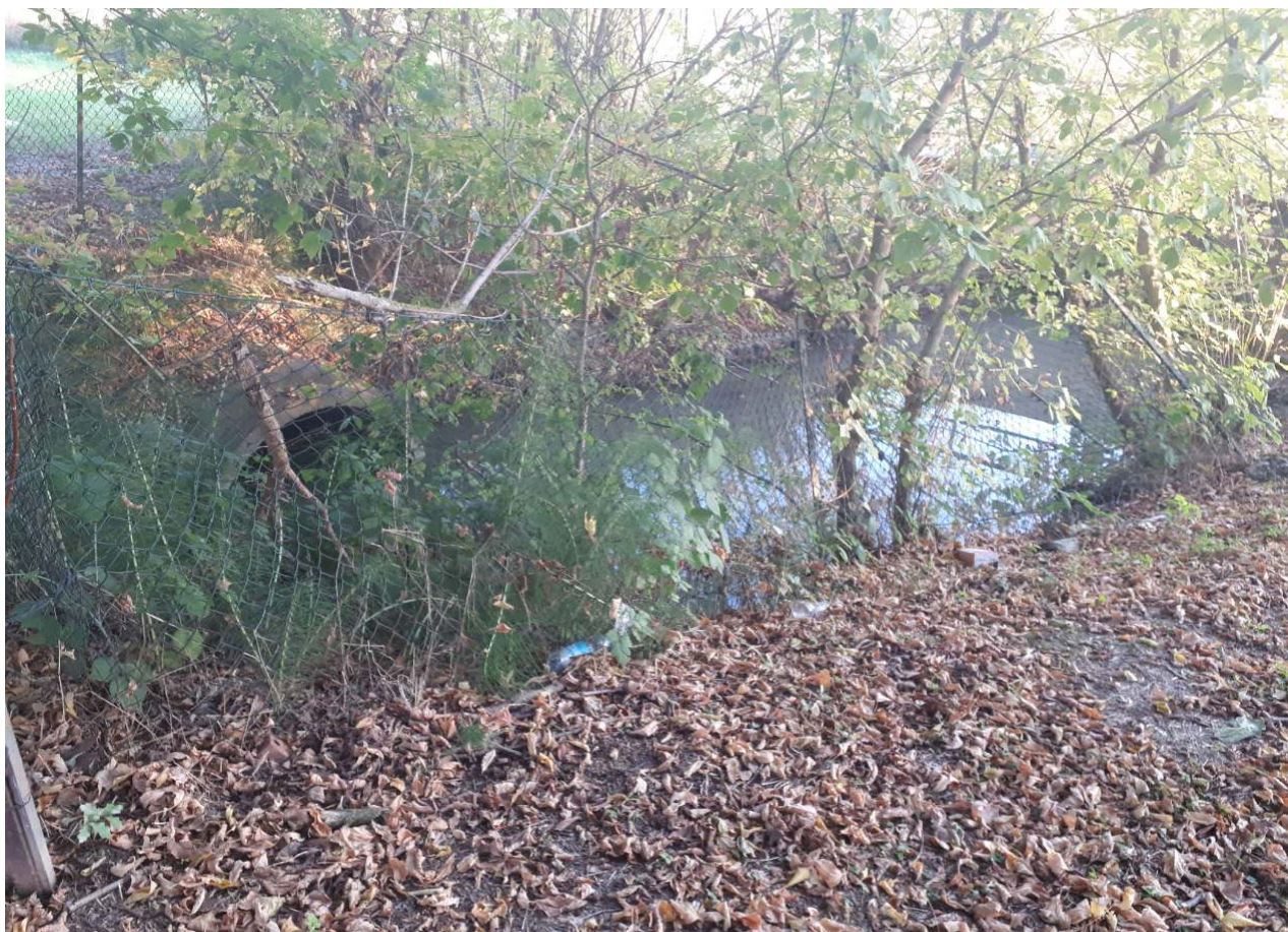
Invaso e condotta esistente proveniente da urbanizzazione limitrofa
