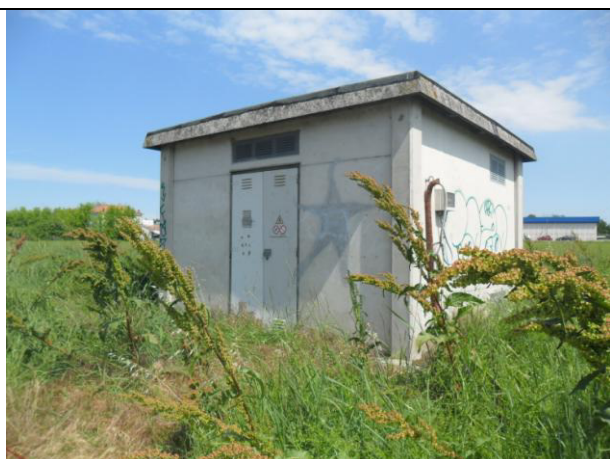
Foto 10 – vista interno lotto (cabina)
