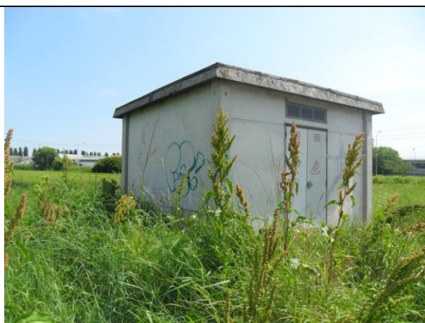
Foto 11 – vista interno lotto (cabina)
