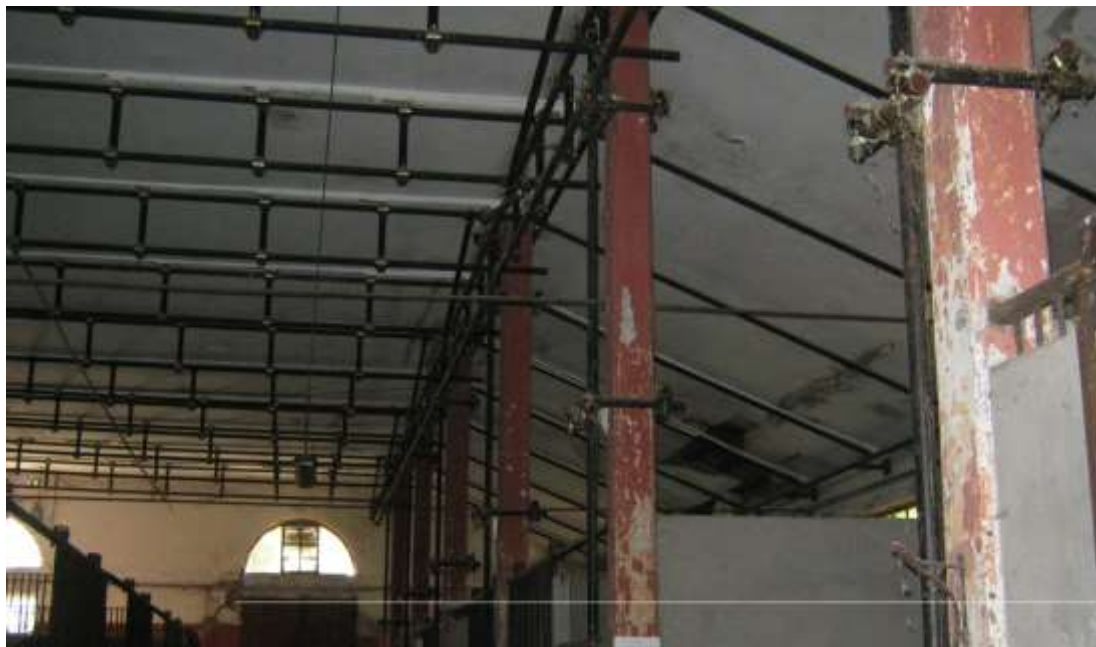
Figura 60 - Pilastri in c.a. lungo una delle file laterali della Scuderia n.4
