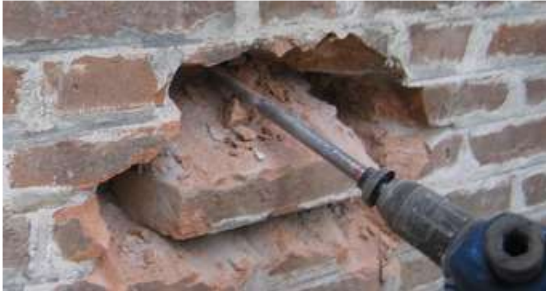
Figura 18 - Prelievo di campione in muratura
