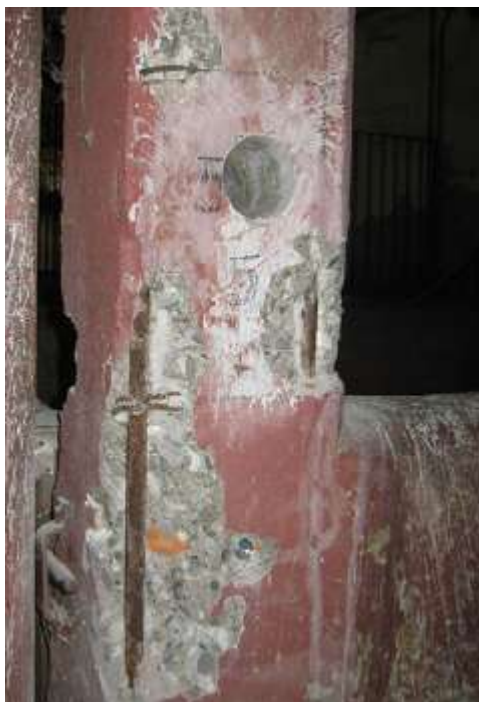
Figura 15 - Rilievo visivo delle armature in un pilastro della scuderia, con prelievo di un campione.
