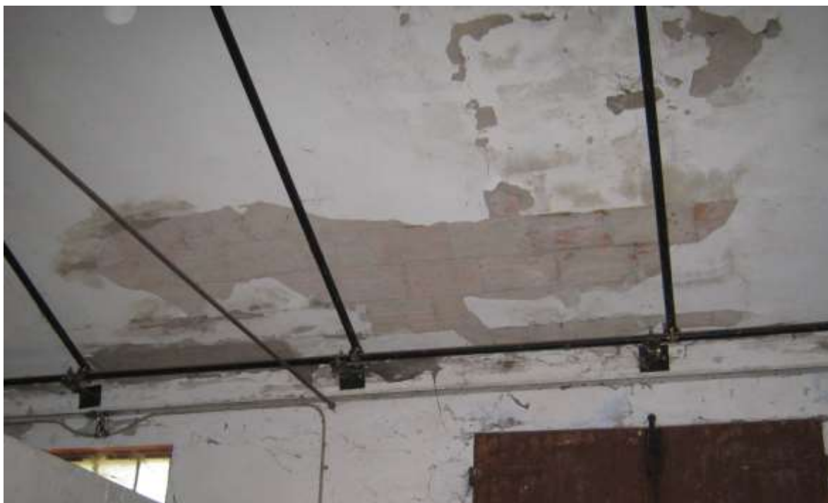
Figura 61 - Scuderia n.4: oltre alla struttura in tubolari metallici con funzione di rinforzo temporaneo, sono visibile le tabelle di chiusura del sottotetto ed una delle catene interne.
