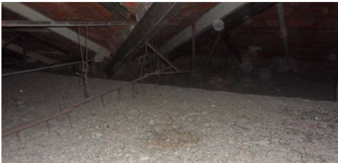
Figura 55 - Chiusura del sottotetto con tavelle in laterizio.
