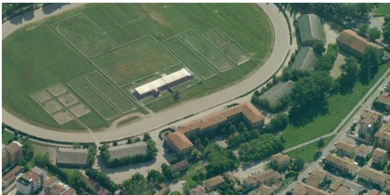
Figura 2 - Veduta prospettica del complesso degli edifici
