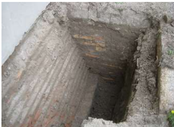
Figura 19 - Operazione di rilievo delle fondazioni
