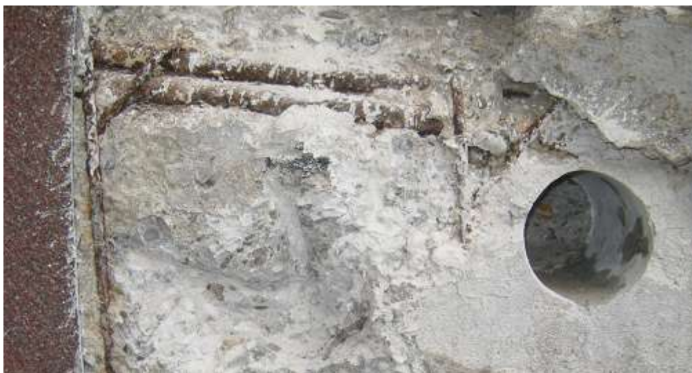
Figura 14 - Estrazione di carote in calcestruzzo
