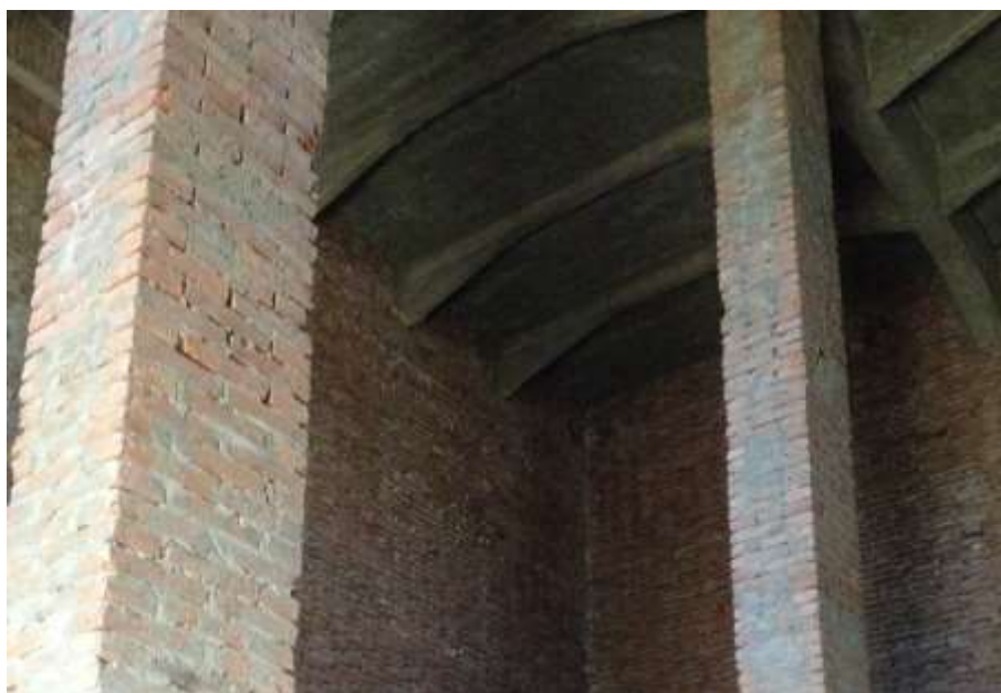
Figura 50 - Pilastri in muratura dell'Edificio Principale
