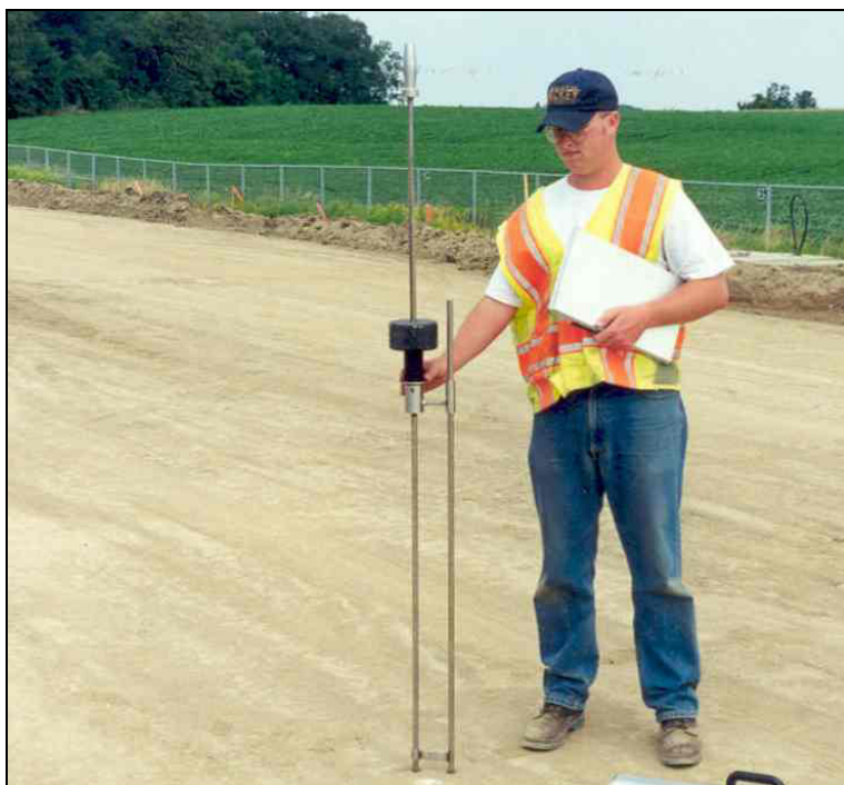
Figura 6: penetrometro dinamico leggero "DCP" standard ASTM D 6951-03
