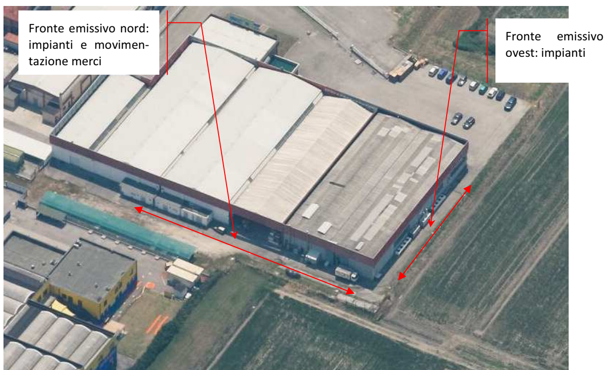
Fig. 4.4 – Vista aerea su stabilimento Vassalli
