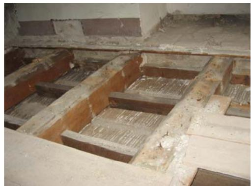
Rimosso il controsoffitto oggi la stanza mostra l'intradosso del solaio ligneo costituito da un solo ordine di travetti posti paralleli ai muri esterni e con fitto interasse che porta il soprastante impalcato; i caratteri strutturali e formali di questo solaio appaiono sostanzialmente modesti ma sono presenti, per la maggior parte del soffitto, listelli coprifili a definire le linee di un cassettonato, ingentilendo il manufatto.
