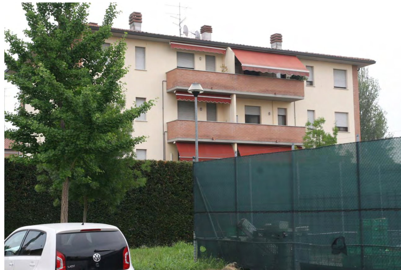
FOTO 27 – fabbricato confinante a nord-est
