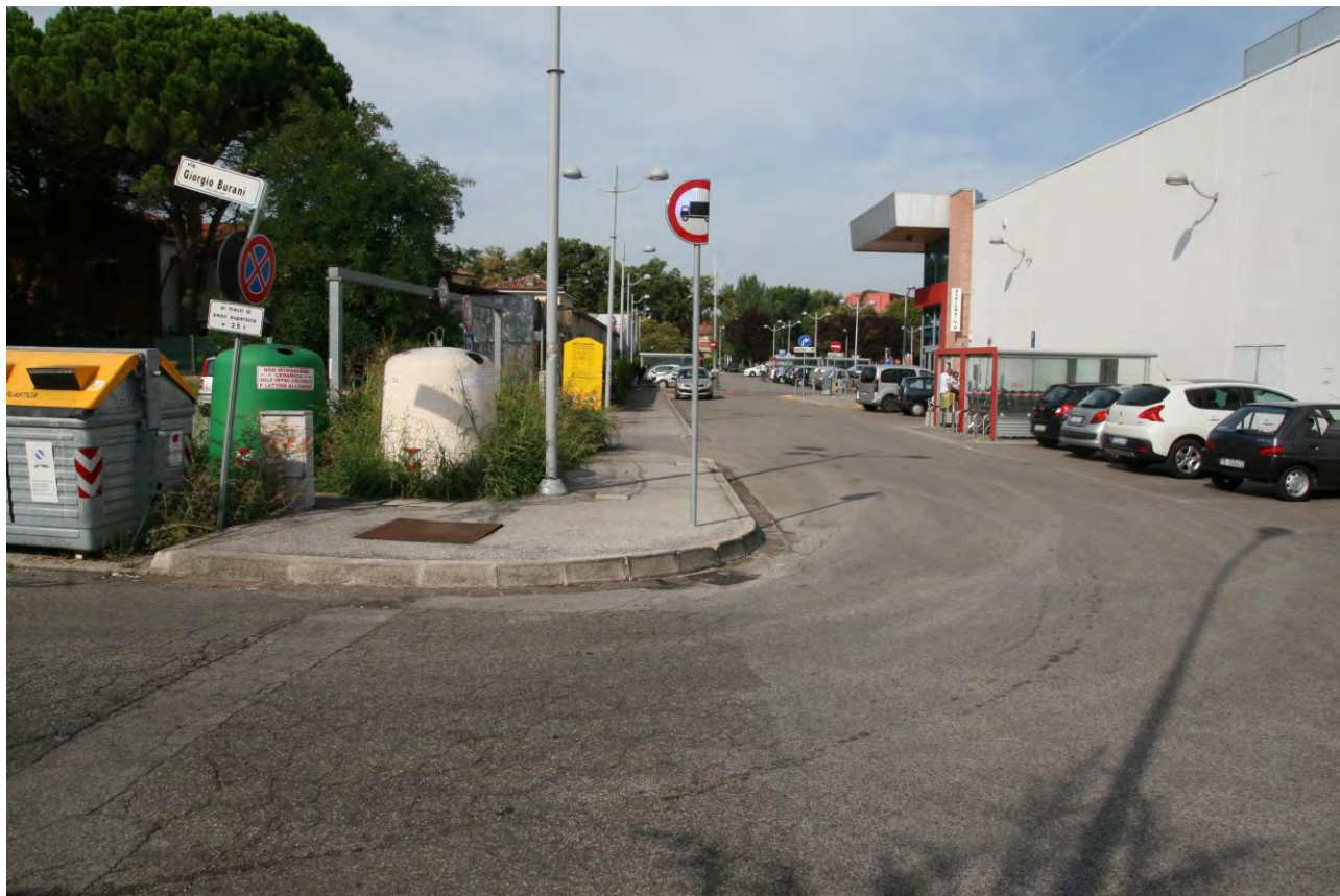
FOTO 13 – collegamento parcheggio privato
