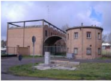
palazzo Savonuzzi, oggetto di ristrutturazione
