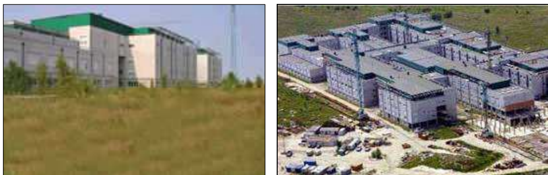
Figure. Esterne di strutture ospedaliere già edificate. [Città di Ferrara, 2008; La Nuova Ferrara, 2008]
