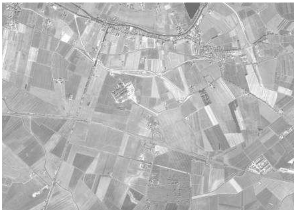
Figura. Ortofotocarta Volo 2002. L'Ospedale prima della ripresa dei lavori
