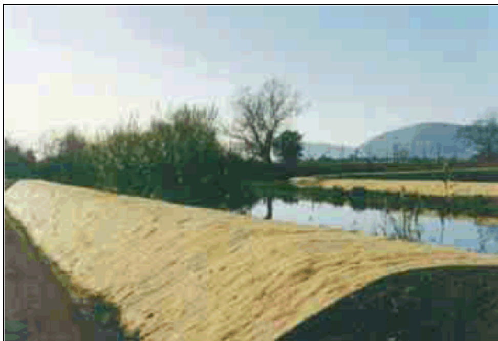
Figura. Rivestimento di rilevati arginali in terra con biostuoia in fibre di legno. [Apat, 2004]. La biostuoia impedirà l'erosione superficiale dando modo alla vegetazione erbacea di crescere e proteggere il terreno in modo permanente, nei confronti delle acque di pioggia e dell'azione della corrente.
