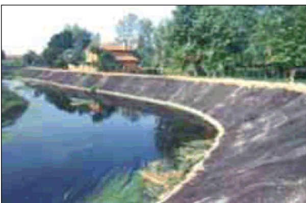
Figure. Protezione di argini fluviali mediante rivestimento con geostuoia tridimensionale piantumata: fase di posa e prima fase di rinverdimento. [Apat, 2004].
