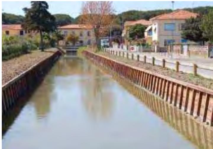
**Figura 5. Esempio di rivestimento in pannelli lignei per il rivestimento ed il sostegno spondale.**
