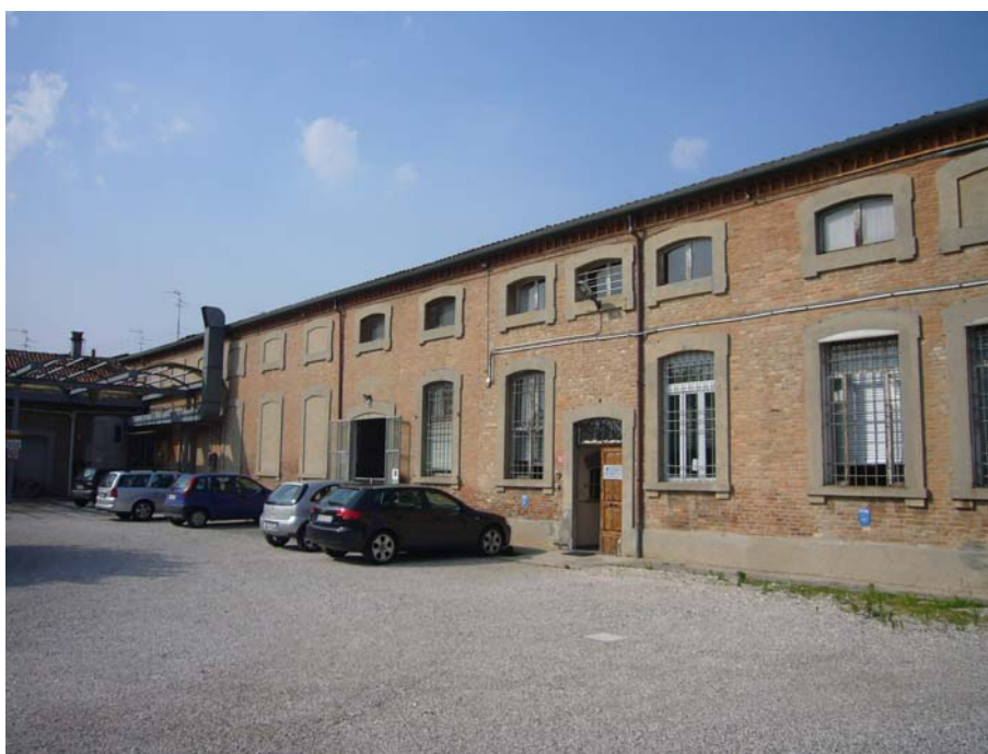
Foto n. 10 Vista fronte principale interno
