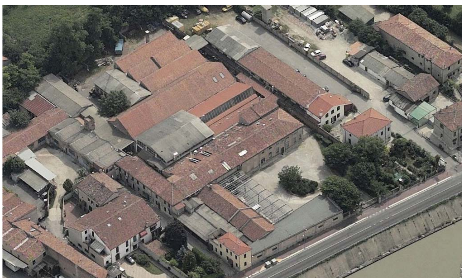
Foto n. 2 Vista aerea a volo d'uccello da Ovest
