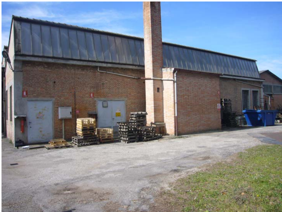
Foto n. 13 Vista lato Nord-Est
