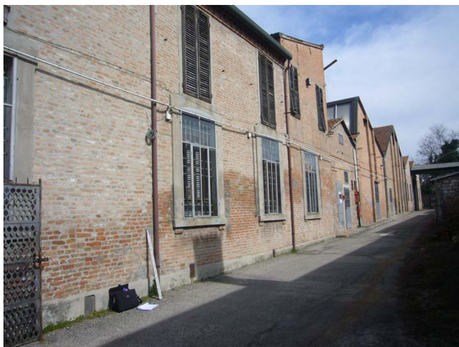
Foto n. 12 Vista lato Sud-Est
