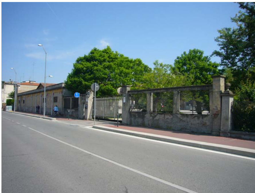
Foto n. 7 Vista da Viale Volano ad Est
