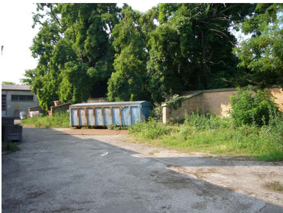
Foto n. 14 Vista della recinzione Nord-Est
