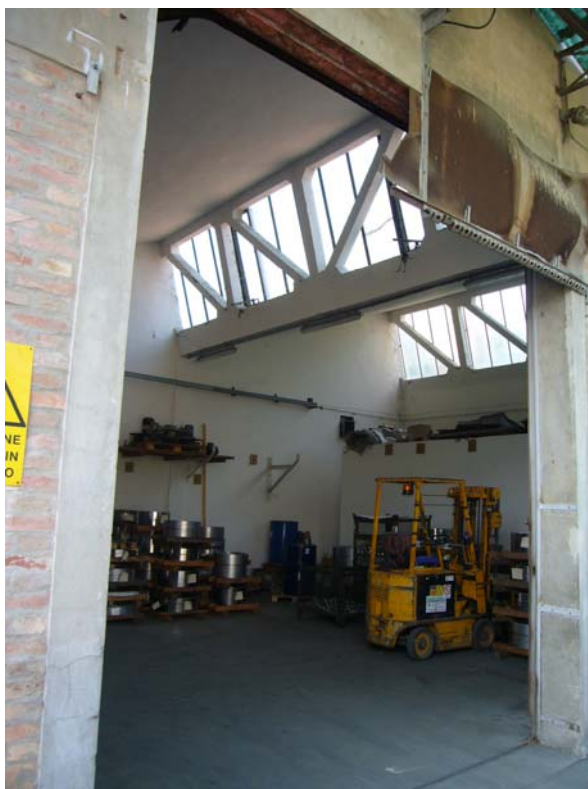
Foto n. 18 Vista interna della copertura a shed
