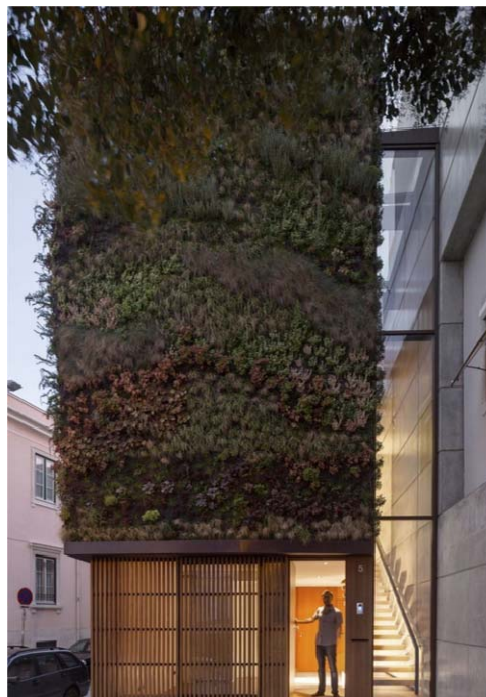
Fig.5 bis Esempio indicativo di parete verde con messa a dimora delle piante in contenitori: House in Travessa de Patrocínio / Luís Rebelo de Andrade + Tiago Rebelo de Andrade + Manuel Cachão Tojal
