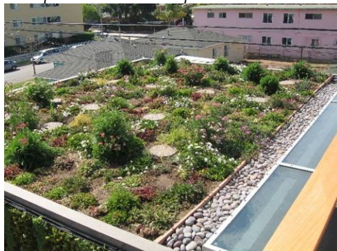
Esempio indicativo di copertura trattata a verde intensivo
