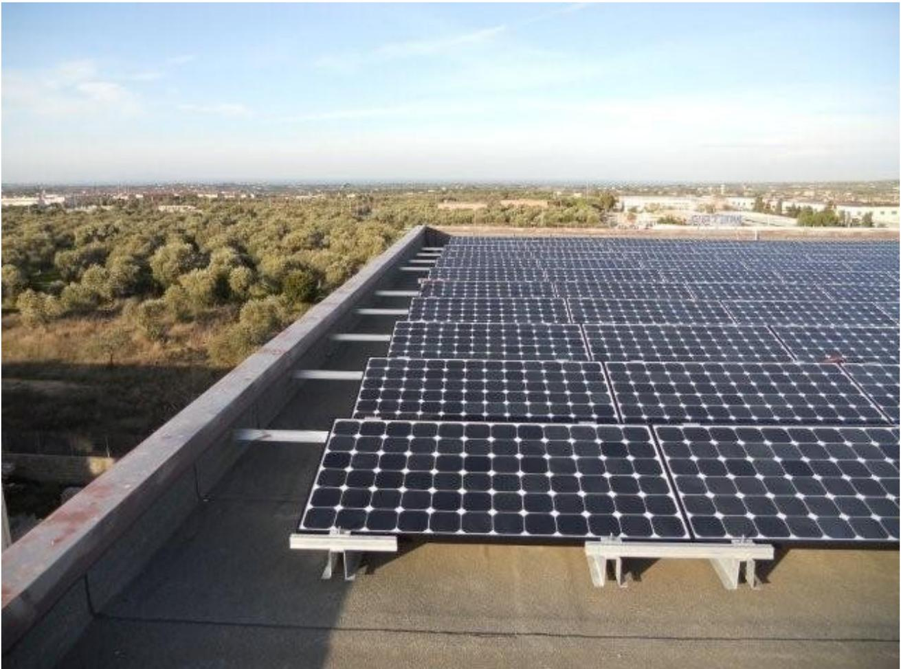
**Figura 17 : Posa pannelli fotovoltaici su copertura piana dell'edificio**
